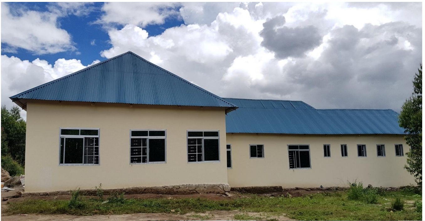
Das Laborgebäude von außen und innen. Befenstert, gefliest und bald auch an die Wasserver- und Entsorgung angeschlossen. (März 2018)
