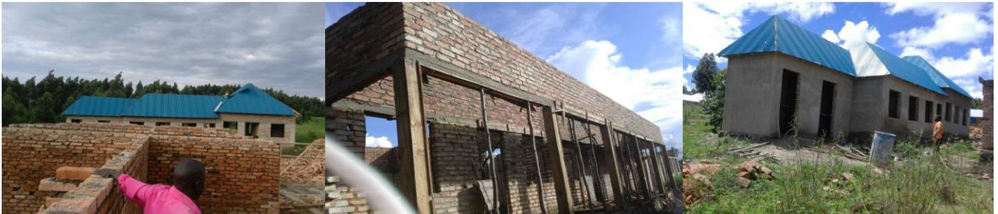
Im Juli wurde damit begonnen, die *Beamline* des Verwaltungs- und Behandlungsbaus fertigzustellen und direkt im Anschluss sollte mit der Dachkonstruktion begonnen werden.
